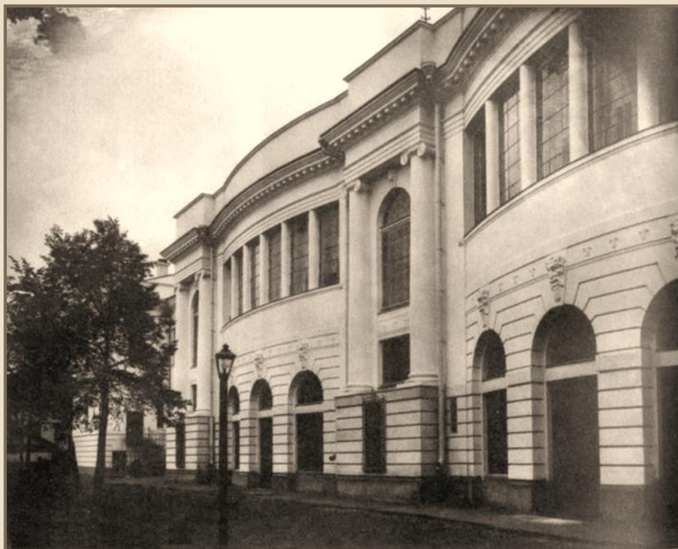
Здание Московского коммерческого института (ныне II корпус РЭУ). После 1913 г.
